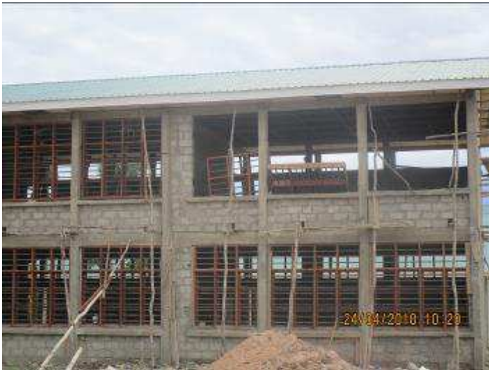
Fig4. Continuité des travaux de menuiserie, pose et fixation des fenêtres au niveau du bâtiment de six auditoires.
